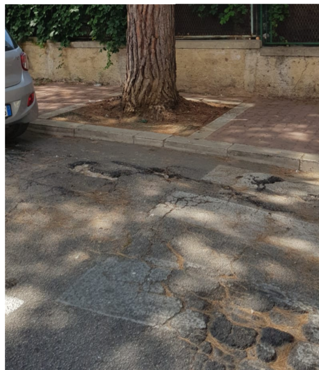
Aiuole e manto stradale deformati, indicatori del conflitto all'interno del sito di radicazione tra gli alberi e i manufatti.
