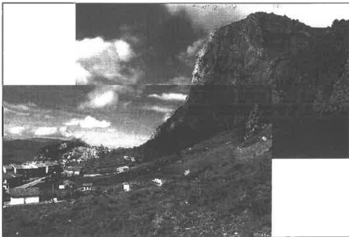
Foto 8 – Vista da sud del pendio a valle del costone roccioso – Si rileva la presenza di numerosi elementi lapidei di dimensioni variabili distaccatisi dal fronte
